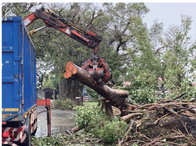
• 林俊憲委員、安盛建築室內裝修公司- 支援夾子車協力清運工作不間斷
